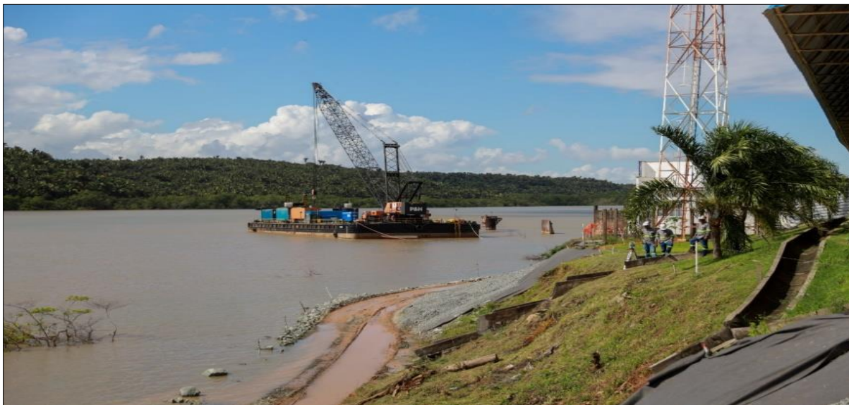
Figura 15 – Obra de revitalização dos Terminais da Ponta da Espera e Cujupe
