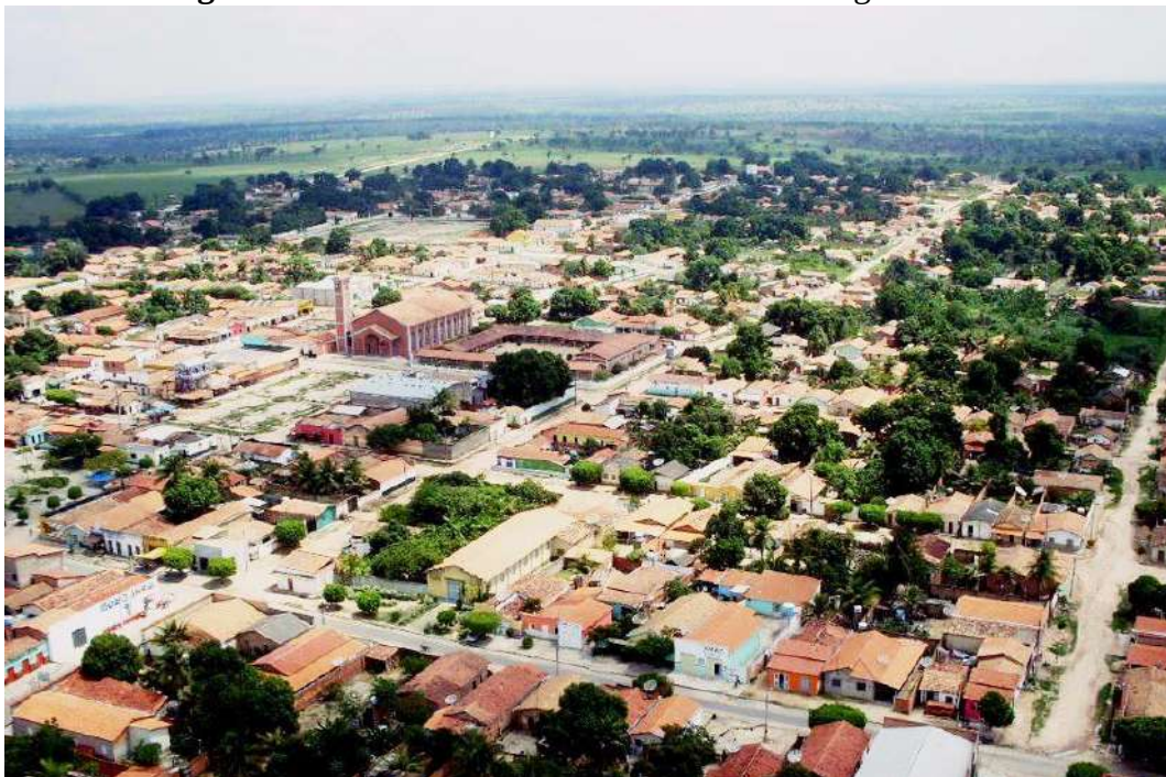
Figura 171 – Vista da cidade de São Pedro da Água Branca
