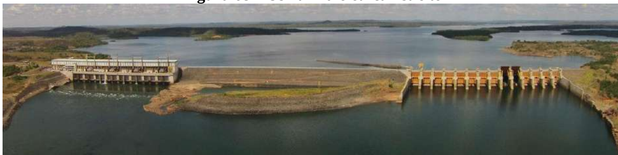
Figura 68 – Usina Hidrelétrica Estreito
