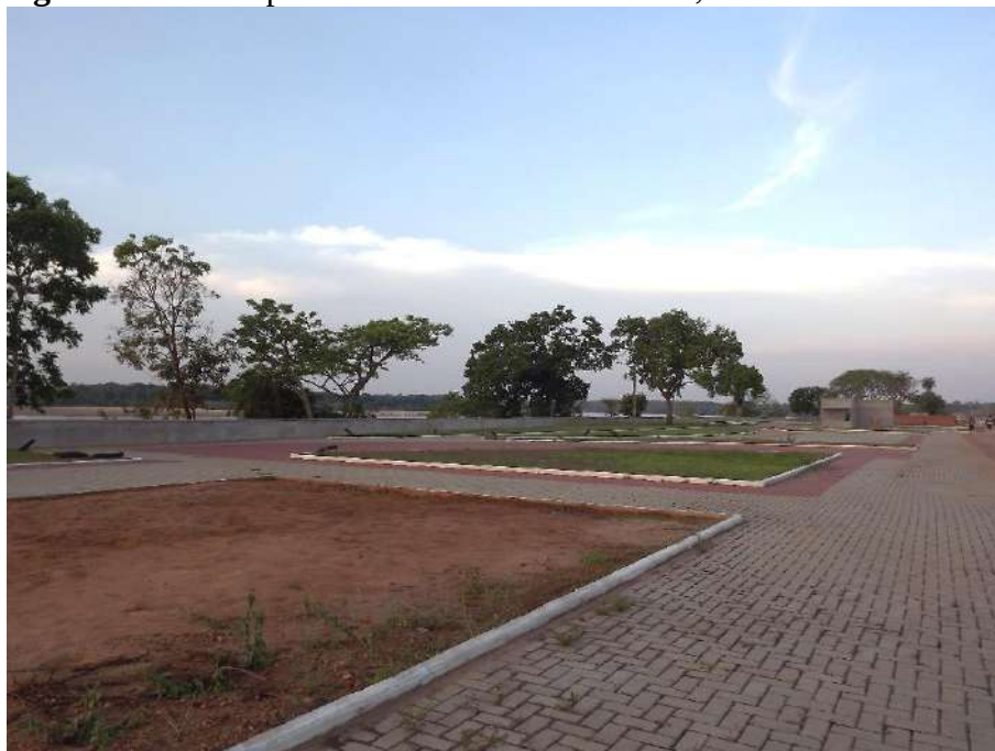
Figura 66 – Vista parcial da beira-rio de Estreito, em fase de conclusão
