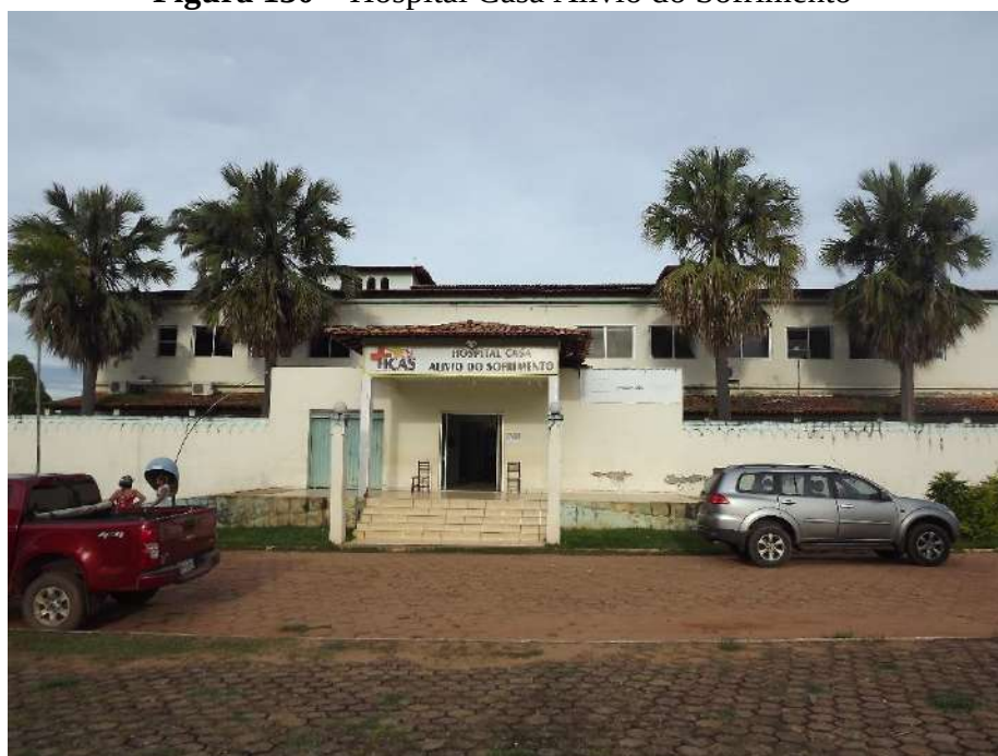
Figura 130 – Hospital Casa Alívio do Sofrimento
