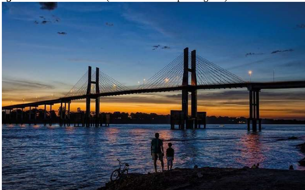
Figura 97 – Ponte estaiada (Dom Afonso Felipe Gregores) sobre o rio Tocantins
