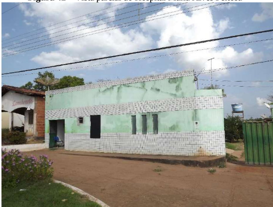
Figura 42 – Vista parcial do Hospital Maria Alves Feitosa
