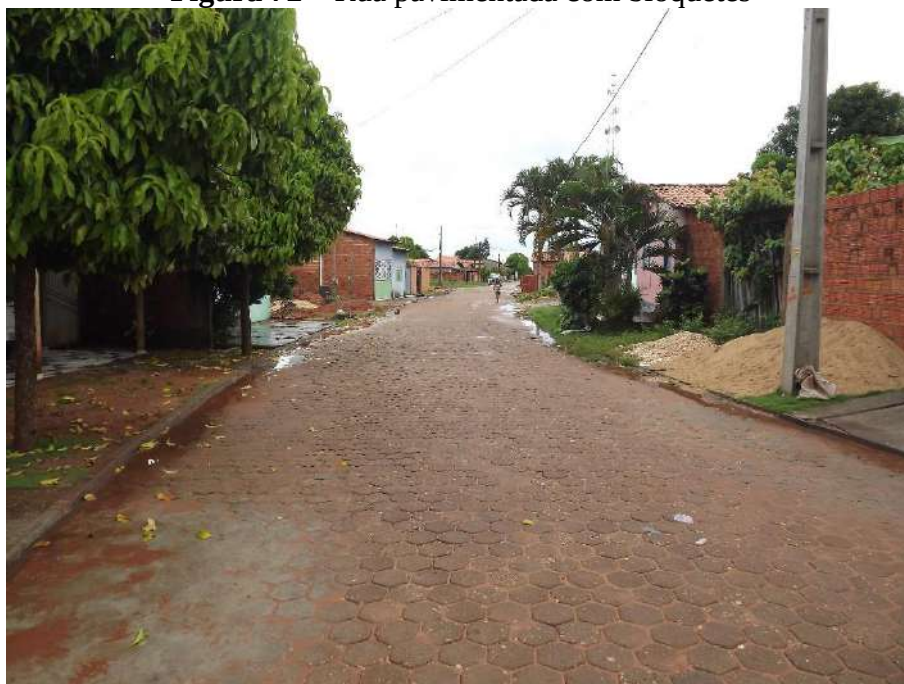
Figura 72 – Rua pavimentada com bloquetes
