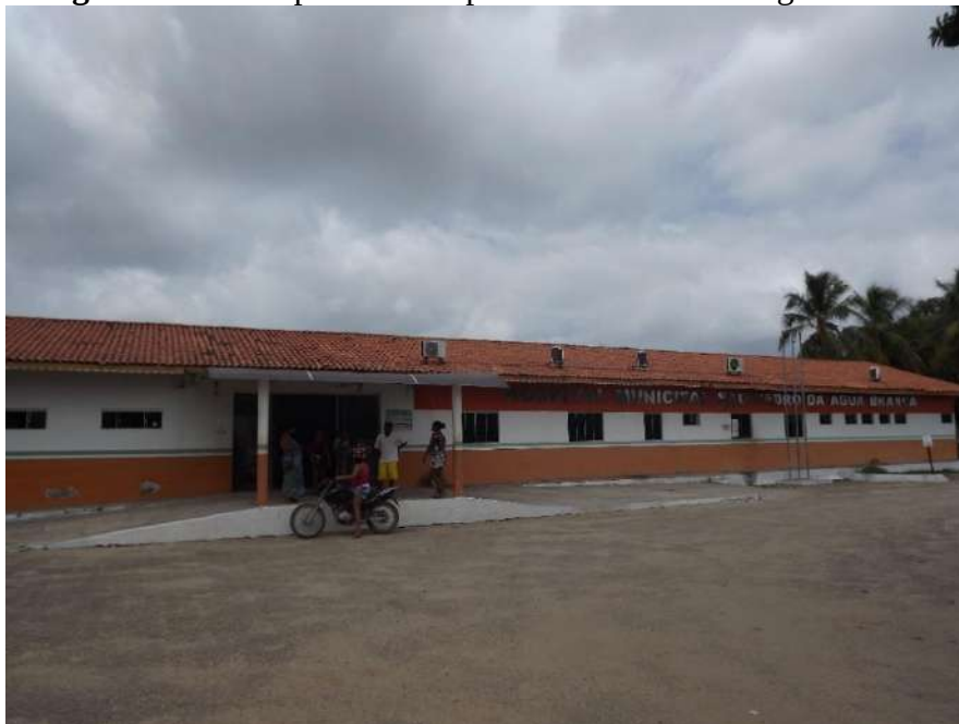
Figura 178 – Hospital Municipal de São Pedro da Água Branca
