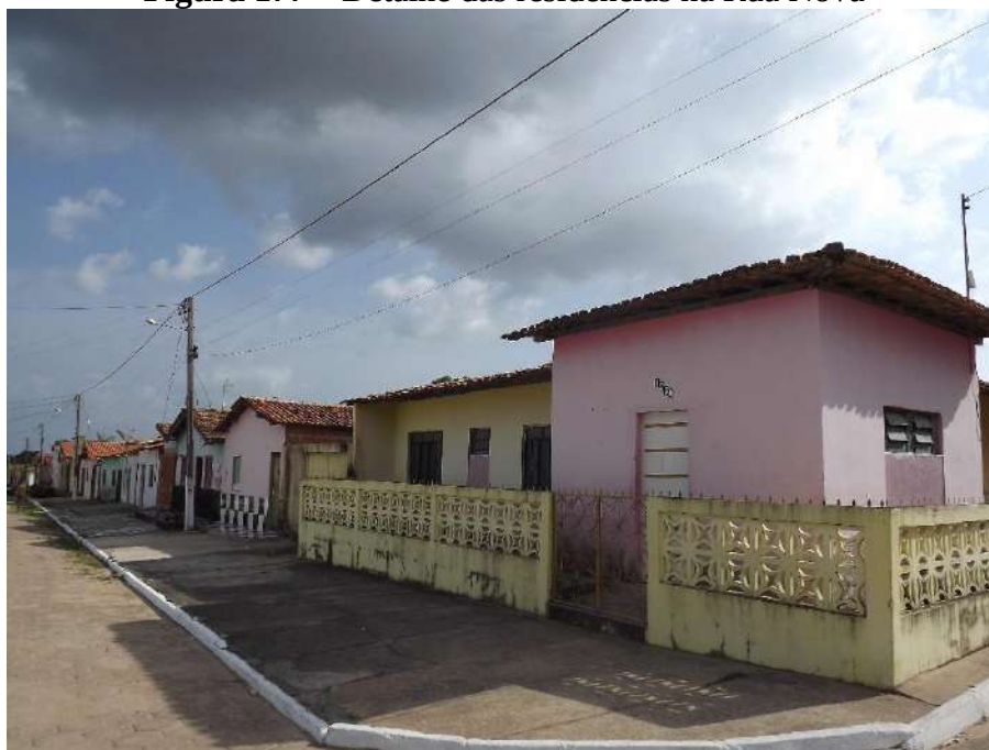
Figura 177 – Detalhe das residências na Rua Nova
