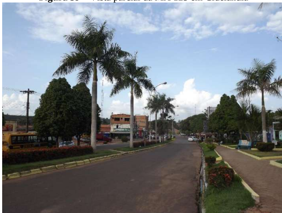
Figura 39 – Vista parcial da MA 125 em Cidelândia
