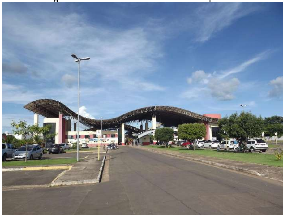
Figura 104 – Terminal Rodoviário de Imperatriz
