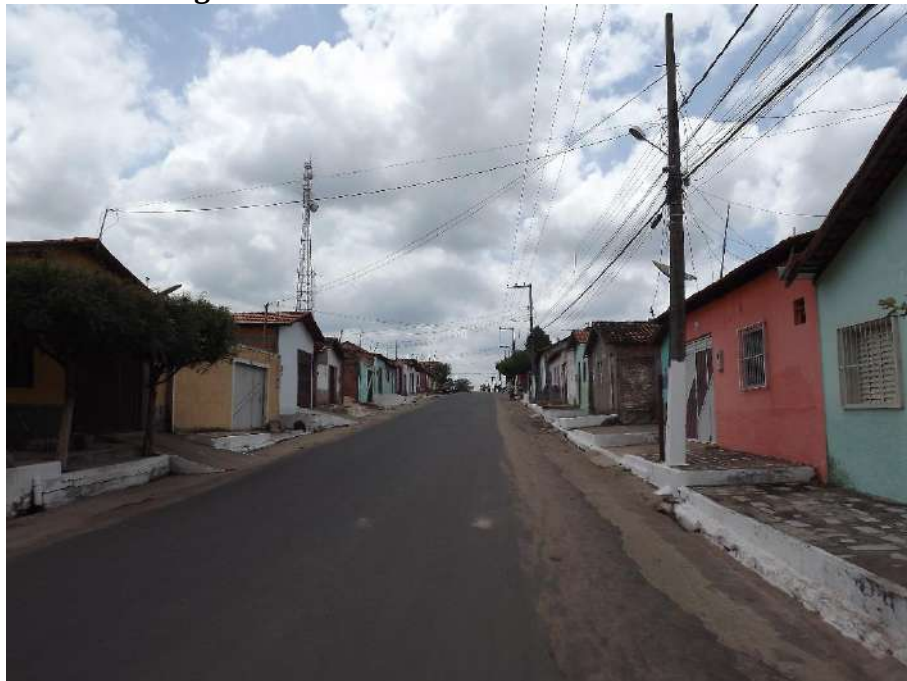
Figura 9 – Padrão construtivo das residências
