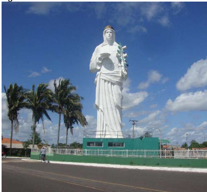
Figura 160 - Monumento de Santa Luzia na entrada da cidade
