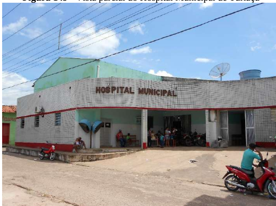
Figura 149 - Vista parcial do Hospital Municipal de Turiaçu
