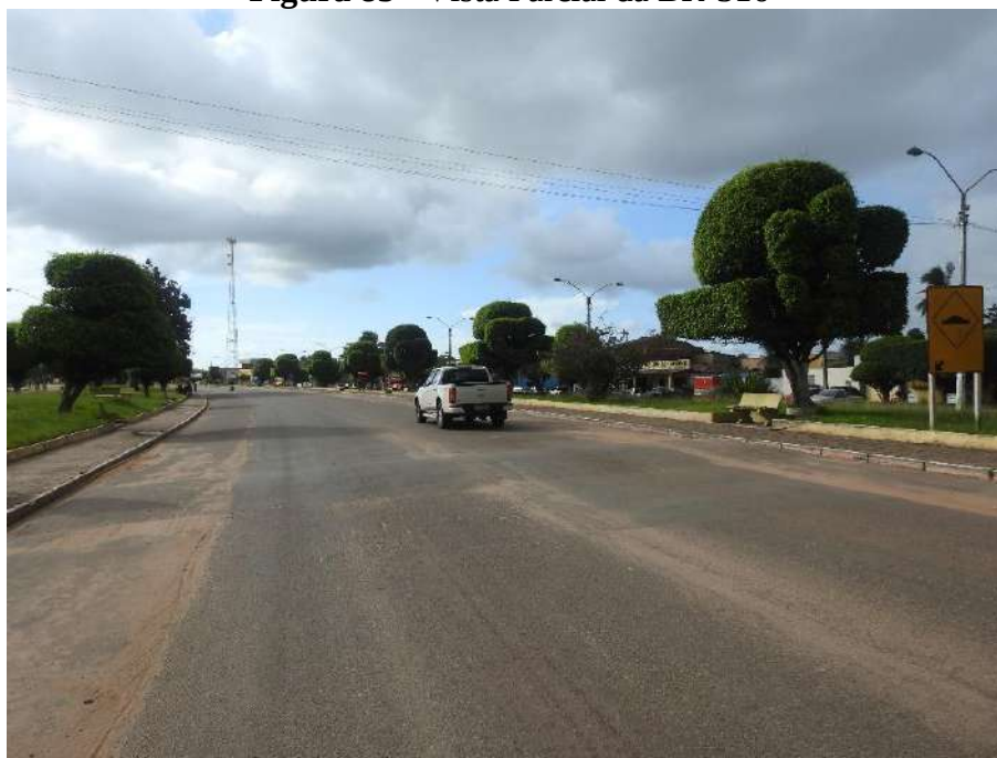
Figura 85 - Vista Parcial da BR-316
