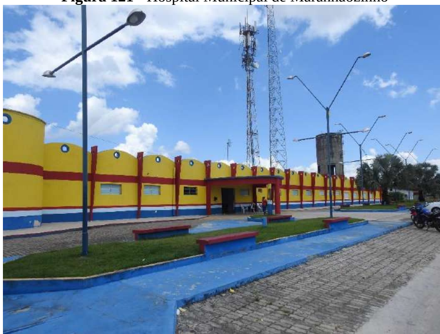
Figura 121 - Hospital Municipal de Maranhãozinho
