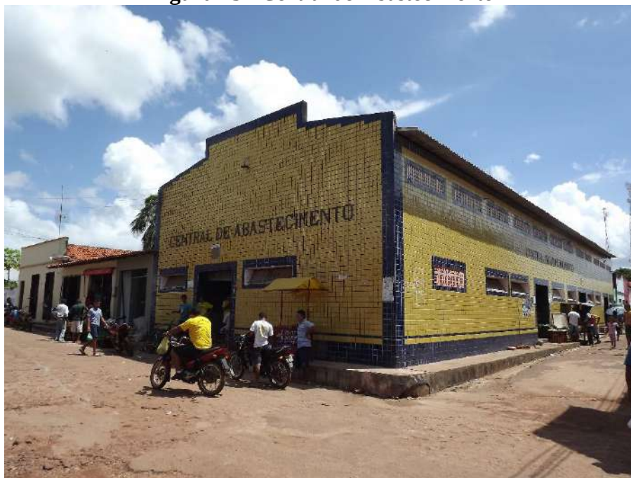
Figura 25 - Central de Abastecimento
