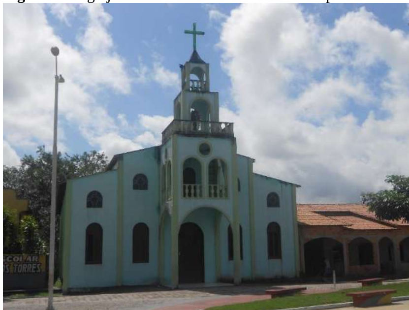
Figura 19 - Igreja Matriz de Nossa Senhora do Perpétuo Socorro
