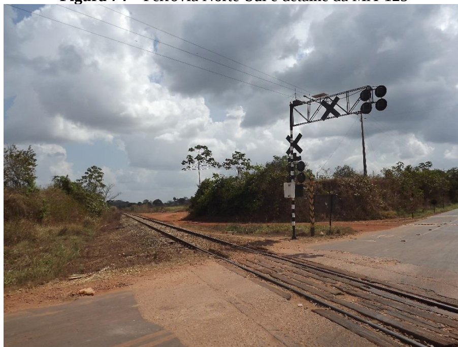
Figura 74 – Ferrovia Norte-Sul e detalhe da MA-125
