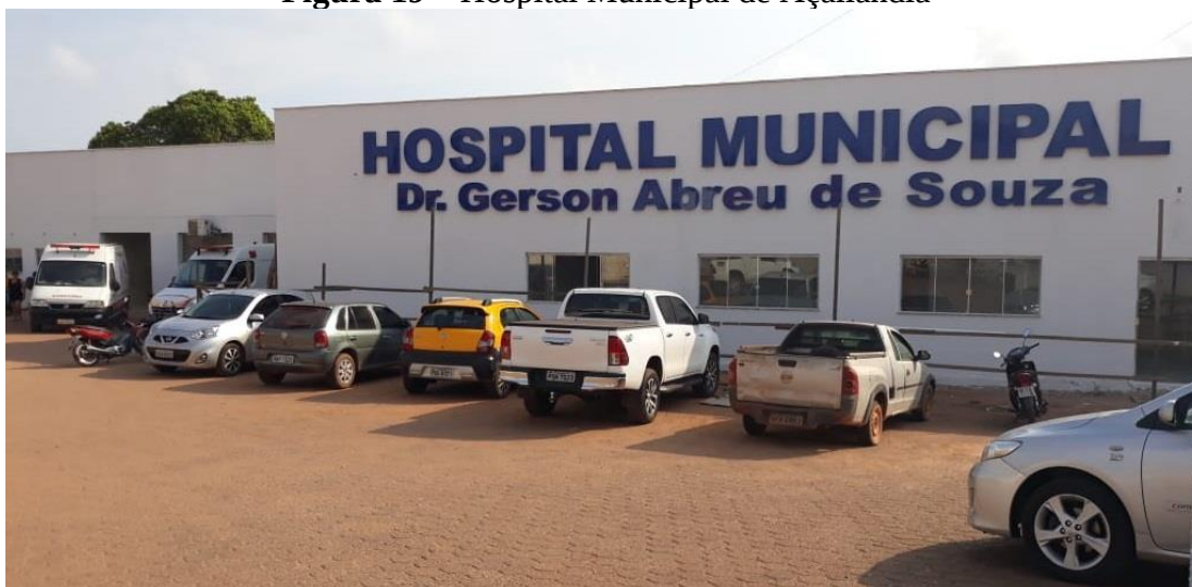
Figura 19 – Hospital Municipal de Açailândia
