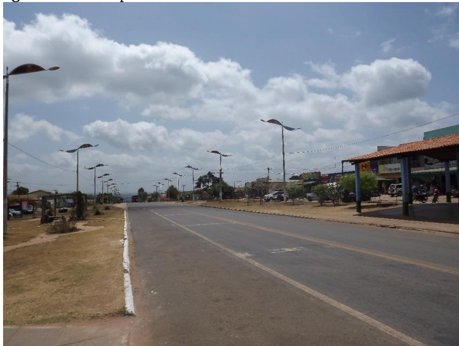
Figura 33 – Vista parcial da BR 222 na cidade de Bom Jesus das Selvas
