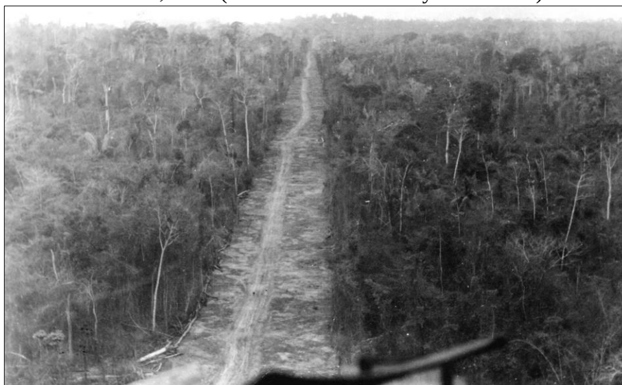
Figura 4 – Construção da rodovia Belém-Brasília, próximo a Açailândia – MA, 1958 (atual Av. Bernardo Sayão – Centro)
