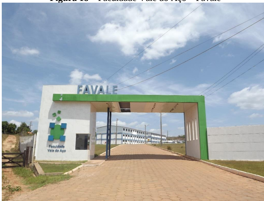
Figura 18 – Faculdade Vale do Aço – Favale
