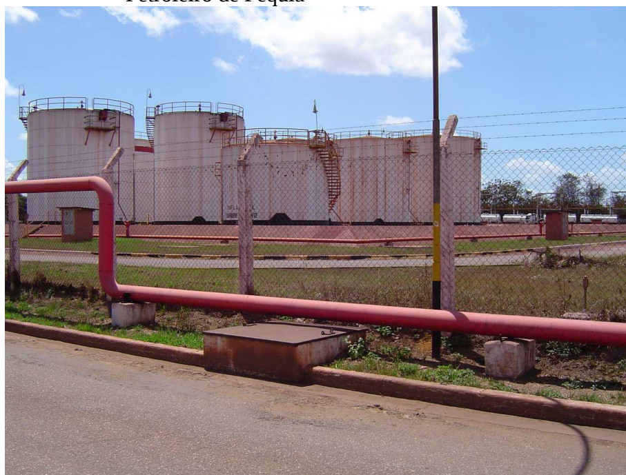
Figura 22 – Tanques de derivados de petróleo e oleoduto do Pool Petroleiro de Pequiá
