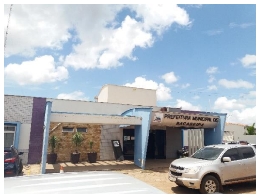
Imagem 40 - Prédio da Prefeitura Municipal de Bacabeira
